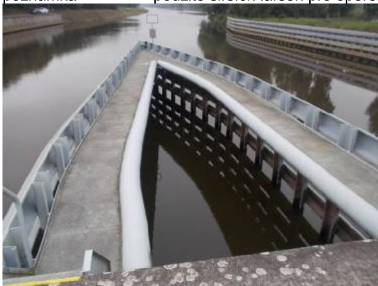
MPK, VPK DO - středová svodidla na konci dělicí zdi PK
