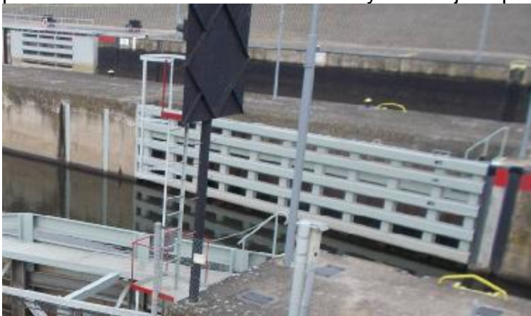
MPK DO PB u vrat - svodidla umístěna v dělicí zdi PK
